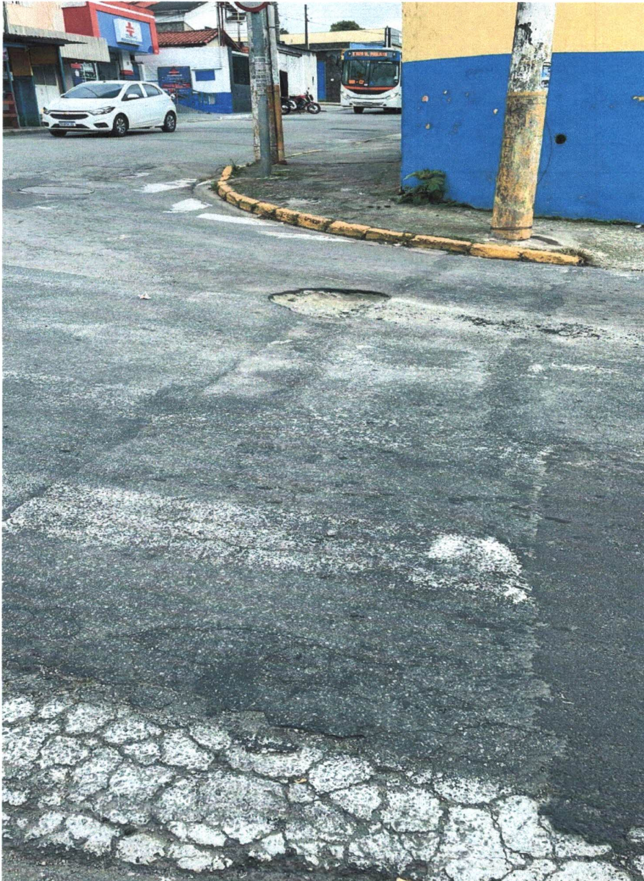
MANUTENÇÃO ASFÁLTICA EM TODA A EXTENSÃO DA RUA MARIO YOSHIDA, VILA CINTRA – MOGI DAS CRUZES.
